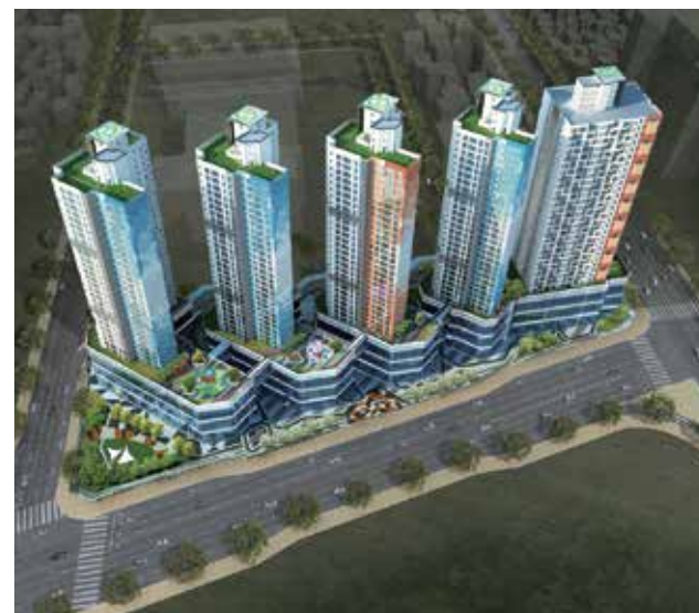
부산 명지국제신도시 삼정그린코아 더베스트 부산광역시 진해 경제자유구역 명지지구 복합6 / 지하 4층 ~ 지상 30층 / 총 863세대
