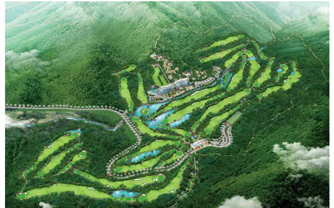
밀양 리더스컨트리클럽 조성공사 규모 : 골프장조성 / 발주처 : (주)리더스컨트리클럽
