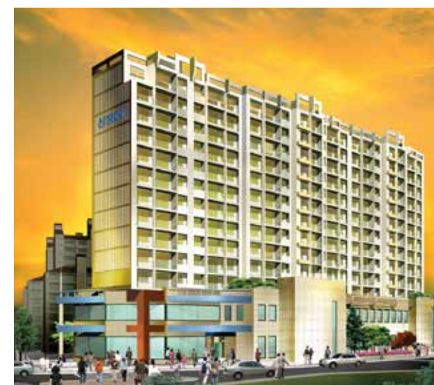
서울 방화동 삼정코아(방신종합시장재건축) 서울시 강서구 방화동 567-4 / 지하3층 ~ 지상13층 / 총 87세대
