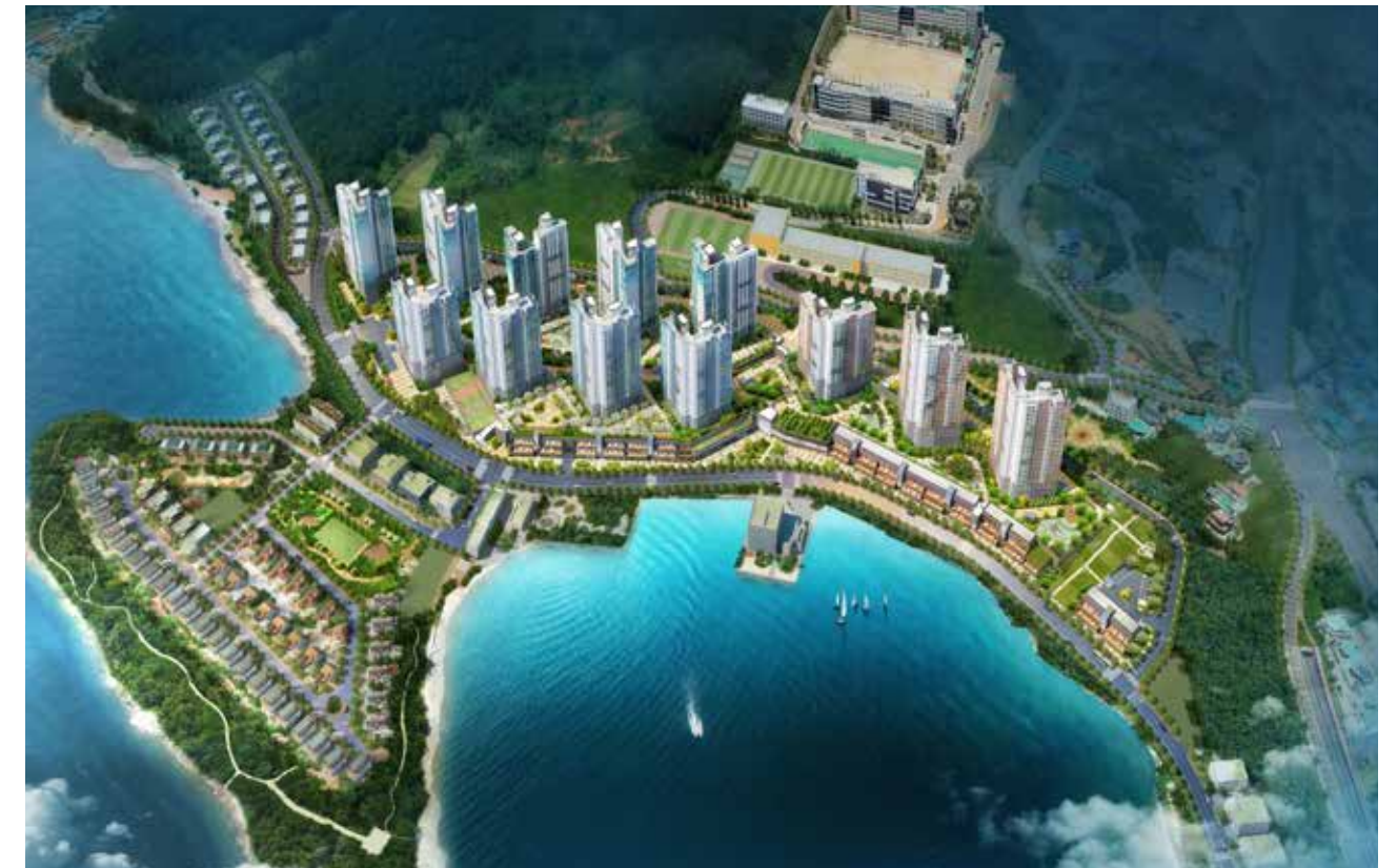
통영 무전 도시개발사업(부지조성, 단지조성) 규모 : 209,352㎡(63,329평) / 발주처 : (주)무전도시개발 / 시공:(주)삼정
