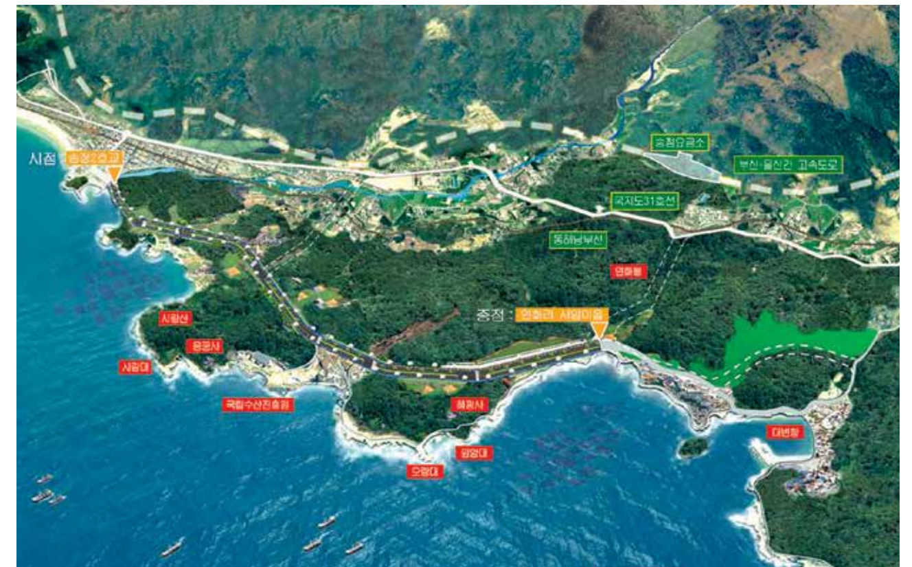
동부산 관광단지 진입도로 확장공사 규모 : 도로확장-L=520m, B=25m / 발주처 : 부산광역시 건설본부
