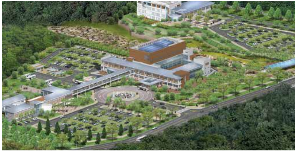
울산 하늘공원 신축공사 규모: 지하 1층~지상 4층, 승하원 외 4개동 / 발주처: 울산광역시 종합건설본부
